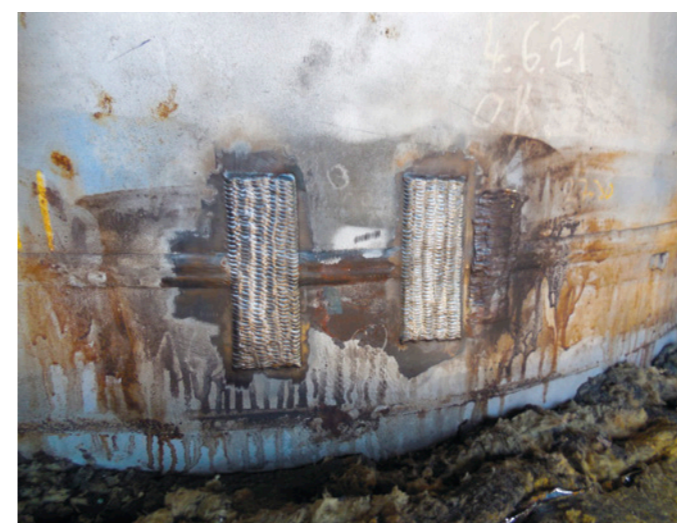
Oprava pláště trubkového reaktoru R 1401E
