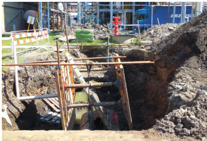
Opravy hlavních rozvodů chladicí a požární vody
