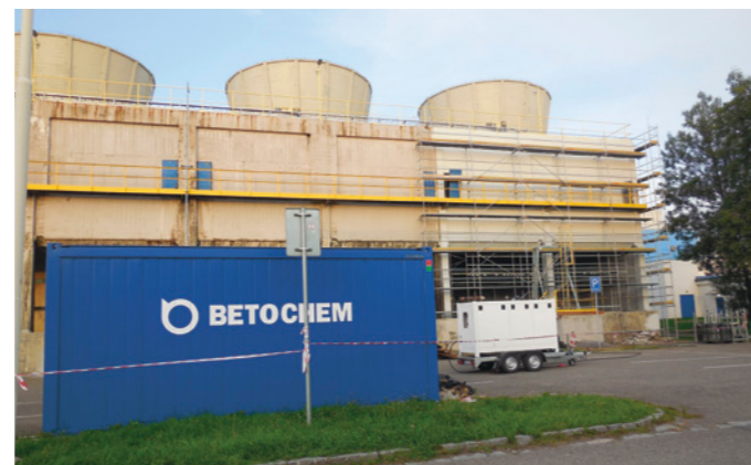
Oprava chladicí věže č. 30 na A bloku
