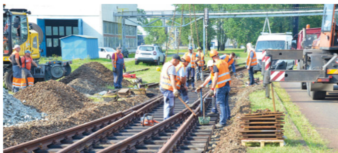
Výměna kolejového dílce pod svážným pahrbkem
