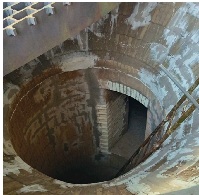
Oprava vyzdívkvy reaktoru R1001
