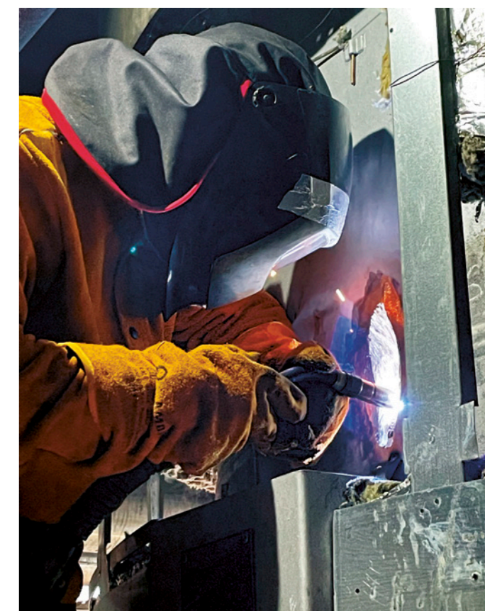
Oprava pláště trubkového reaktoru R 1401E
