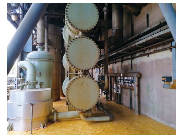
Oprava výměníků „trojčat“ E1402 D
