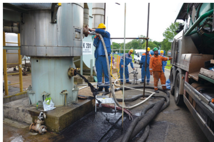
Výměna katalyzátoru v odsiřovacím reaktoru
