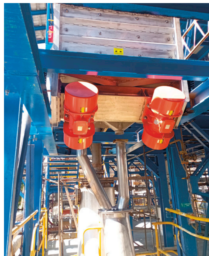
Pohled ze spodní části násypky vibračního mlýna
